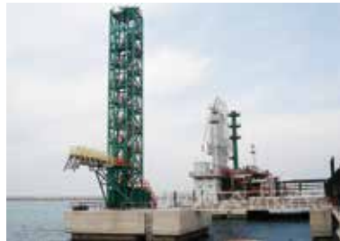
Pasarela telescópica de tipo torre instalada en puerto.
