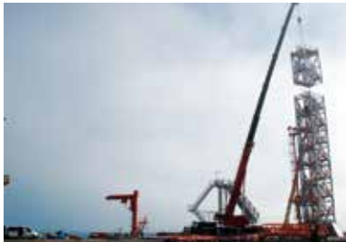
Montaje de pasarela telescópica tipo torre en puerto.
