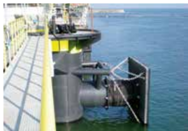
Defensa tipo SC instalada por Prosertek.
