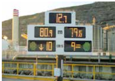
Display del sistema de asistencia al atraque instalado en terminal LNG.
