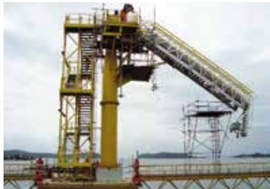
Montaje de pasarela telescópica tipo columna en Duque de Alba.
